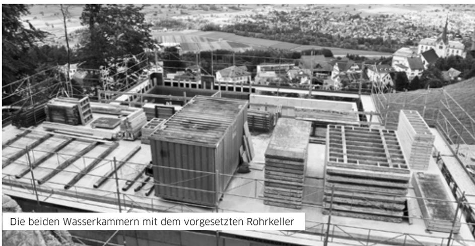
Die beiden Wasserkammern mit dem vorgesetzten Rohrkeller
