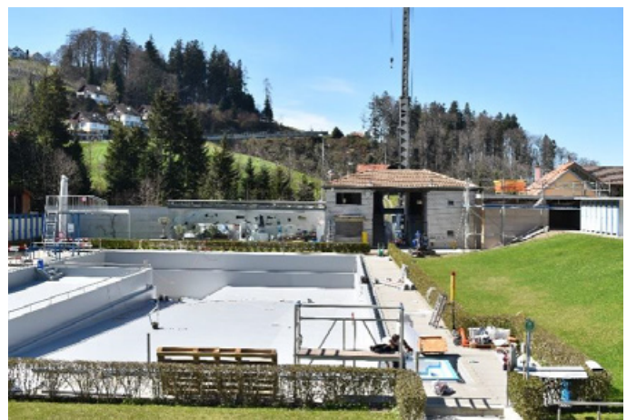
Neue Folie für das Schwimmbecken
