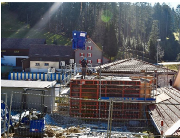
Betonarbeiten am Ergänzungsbau
